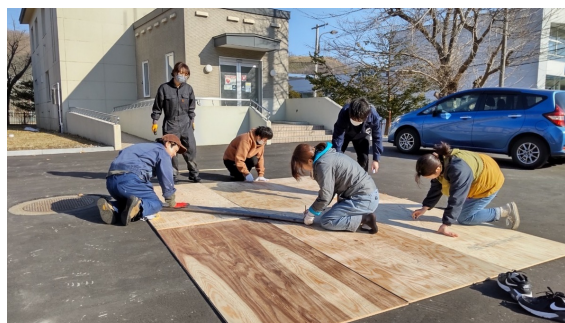
図3 墨出しの様子
