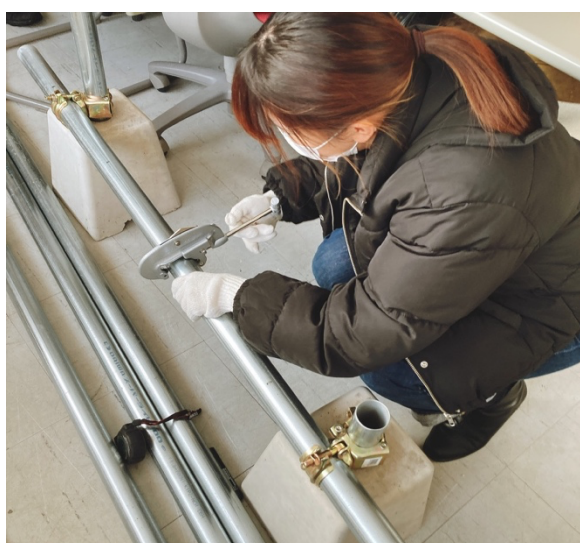
図 8 単管パイプカット
