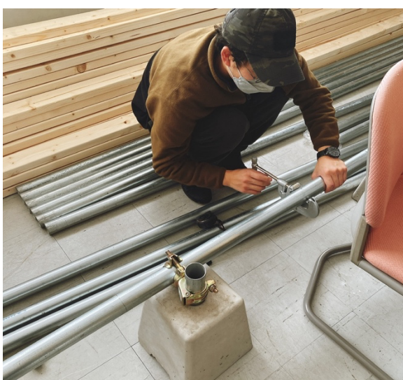
図 9 単管パイプカット
