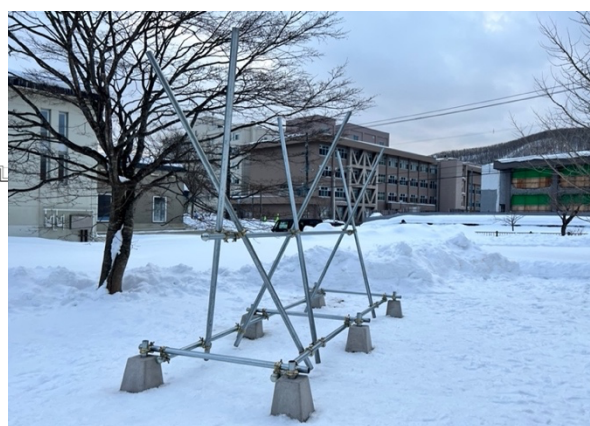
図2 ベンチ骨格完成写真
