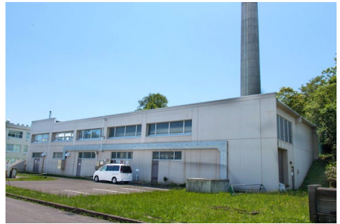
⑳パワーセンター
