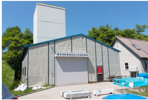
⑲衝撃試験機室
