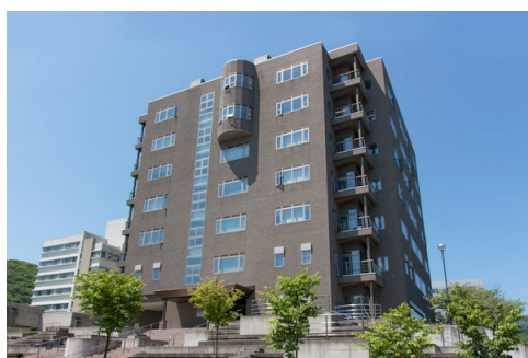
⑨教育・研究7号館（Y棟）
