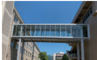
連絡通路「そらみち」 令和2年7月完成
