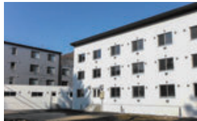
明涼館(女子寮)B棟 平成28年3月完成
