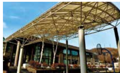
▲N棟-図書館接続空間「リクミチ」
