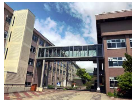
渡り廊下「そらみち」
