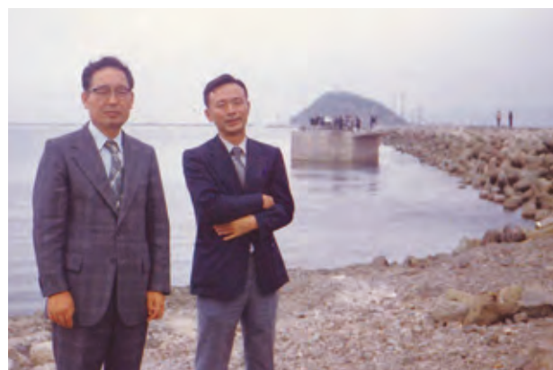
実験プラントケーソン(写真右/近藤倅郎、左/渡部富治) 1980年7月
