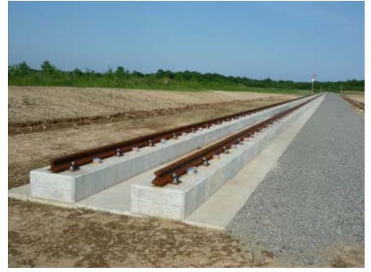
高速走行軌道試験設備
